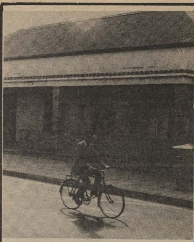
Die ou Konservatorium gaan binnekort gesloop word. Die gebou is vir R35 000 verkoop. 'n Woonstelgebou wat die tweede grootste in Potchefstroom sal wees, gaan daar opgerig word.
