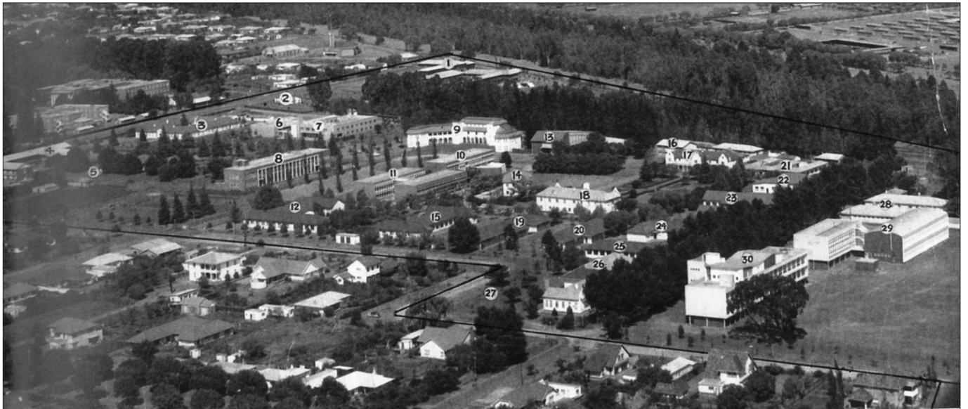
Die PUK-kampus teen die sewentigerjare (Bron: PUK-Argief)
