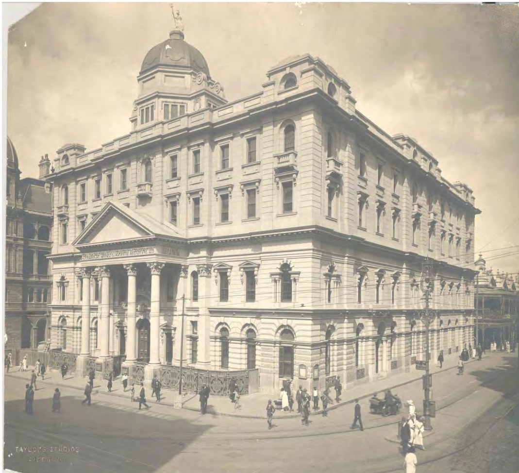
Figuur 5.7: Standard Bank se Adderleystraattak, Kaapstad, na die byvoeg van twee verdiepings, circa 1923 (Foto: Standard Bank).
