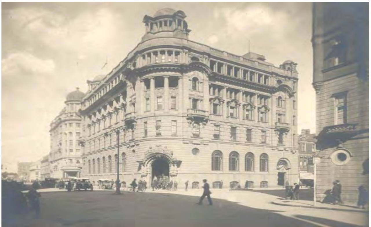
Figuur 5.13: Standard Bank se Commissionerstraattak in Johannesburg. Die eerste van die "bankpaleise" (Foto: Standard Bank)
