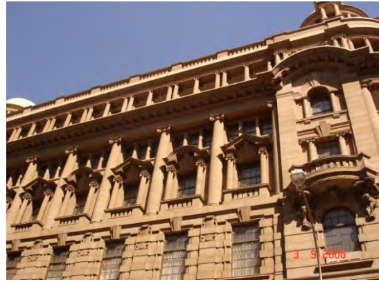
Figuur 5.16: Besonderhede van argitektuur, oosfasade, Standard Bankgebou, Commissionerstraat, Johannesburg (Foto IP de Swardt, 2006)
