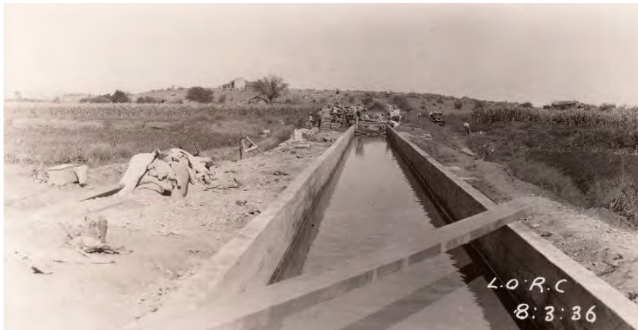
Figuur 3.14: Versterkte kanaal in Roikopeiland onder konstruksie. 133
