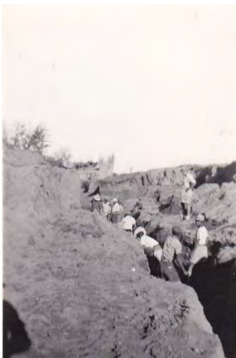
Figuur 5.10: Regs: Werkers besig om die sugsloot uit te grawe, 1956. 107
