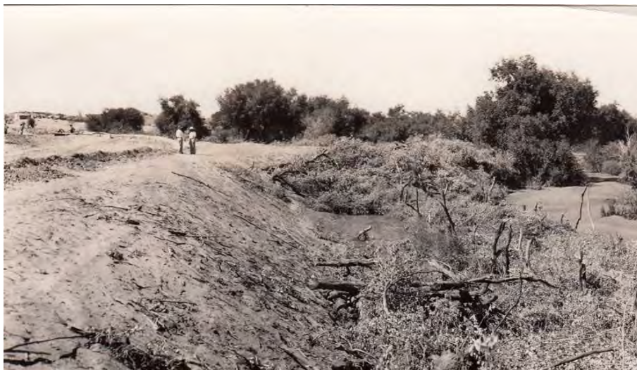
Figuur 3.45: Die opsleep van noodwalle en die kanaal was 'n prioriteit. Links agter is 'n nedersettershuis sigbaar. 315
