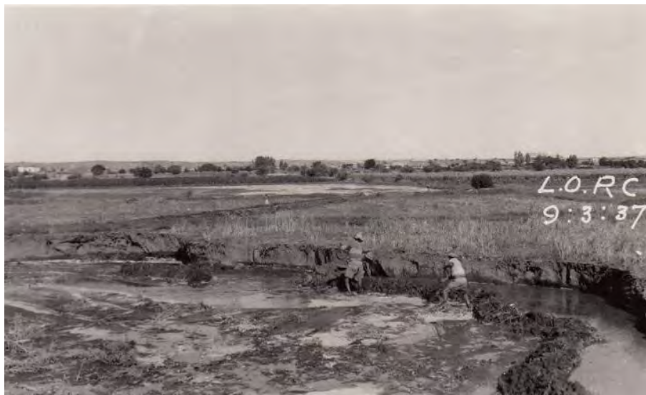
Figuur 3.54: Spoelwerk in Kakamas, Renosterkop. Spoelmanne besig om die spoelsloot te versterk. Soortgelyke spoelwerk is in Skanskopeiland gedoen. 379
