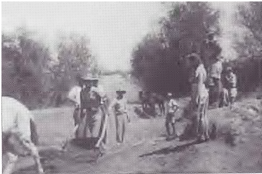
Figuur 3.49: Die kanaalwalle word opgesleep met bakskrapers. 342
