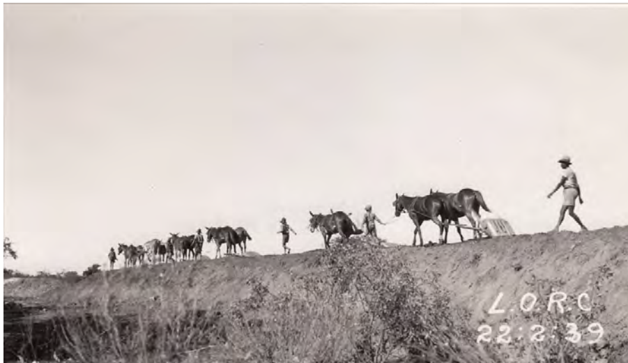
Figuur 3.51: Sleepspanne in die Kakamas-arbeidskolonie. So is daar met baksrapers gewerk in Skanskopeiland. 359
