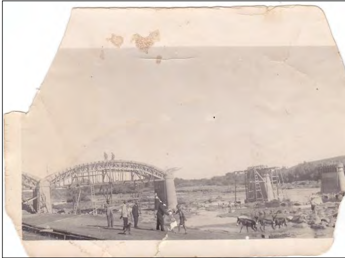
Figuur 2.8: Groblersbrug in aanbou. 145
