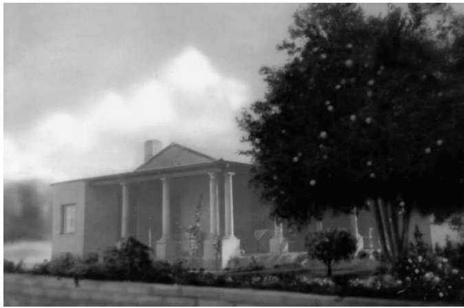
Figuur 5.15: Die woning van C.F. Pool, ongeveer 1948 gebou. 168
