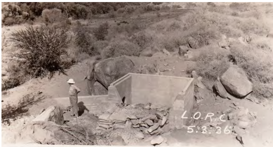
Figuur 3.13: Bouwerk aan die sifon of duikpyp. 121
