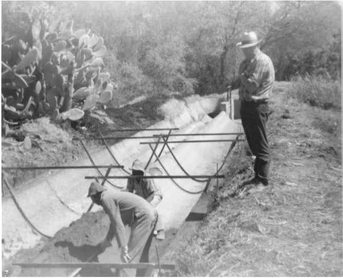
Figuur 5.12: Die wyse waarop die kanaal se betonkleding met die parabool gedoen is, gefotografeer tydens herstelwerk. 138
