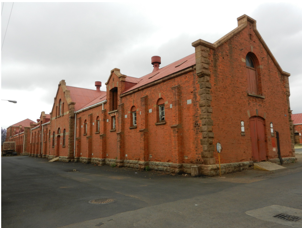
Illustrasie 23: Perdestalle by die Staatsartillerie, Pretoria. Voer vir die perde is in die soldervertrekke gehou (sien boonste deure op foto) en afgegooi ondertoe. Foto: Linda Brink, 11 Oktober 2014.
