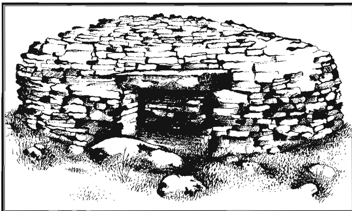
Illustrasie 28 Korbeelhutte van klip naby die Sandrivier op die Potchefstroompad. 244 Kyk ook hieronder. Vroeë klipbouwerk in die vorm van die tradisionele koepel- of byekorfvorm op die Vrystaatse Hoëveld. 245
