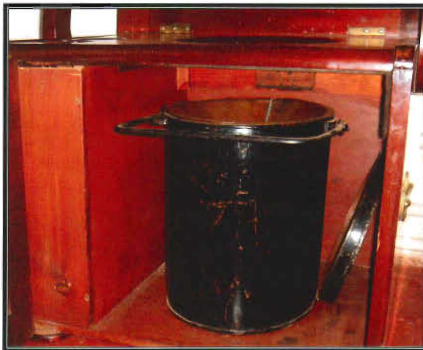
Illustrasie 77 Die draagbare emmertoeilet wat met water gespoel het op Zwartkoppies. 490
