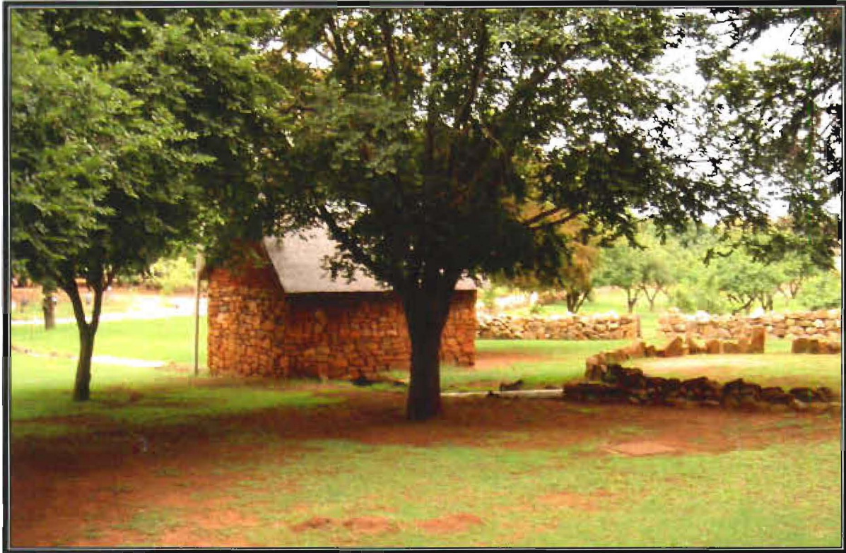
Illustrasie 18 Die watermeul (Noormansmeul) op Hartbeespoort, Pretoria. 127 Die klip- en roukleisteengebou staan teen 'n skuinste. Die gepakte modder-en-klipwatervoor loop onder deur die struktuur en die wiel met skeppers is binne geplaas. Let op die gepakte klipmuur om die vrugteboord (in die agtergrond) en om die dorsvloer (regs).
