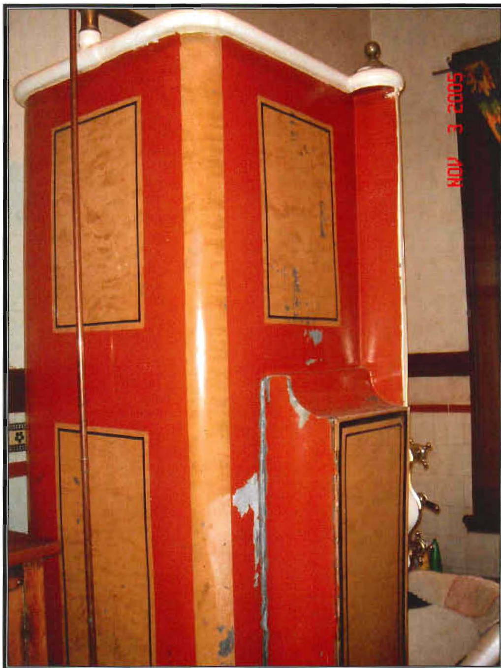
Illustrasie 72 Die stortbad se skerm. Let op die koperwaterpyp van die stortgedeelte. 485
