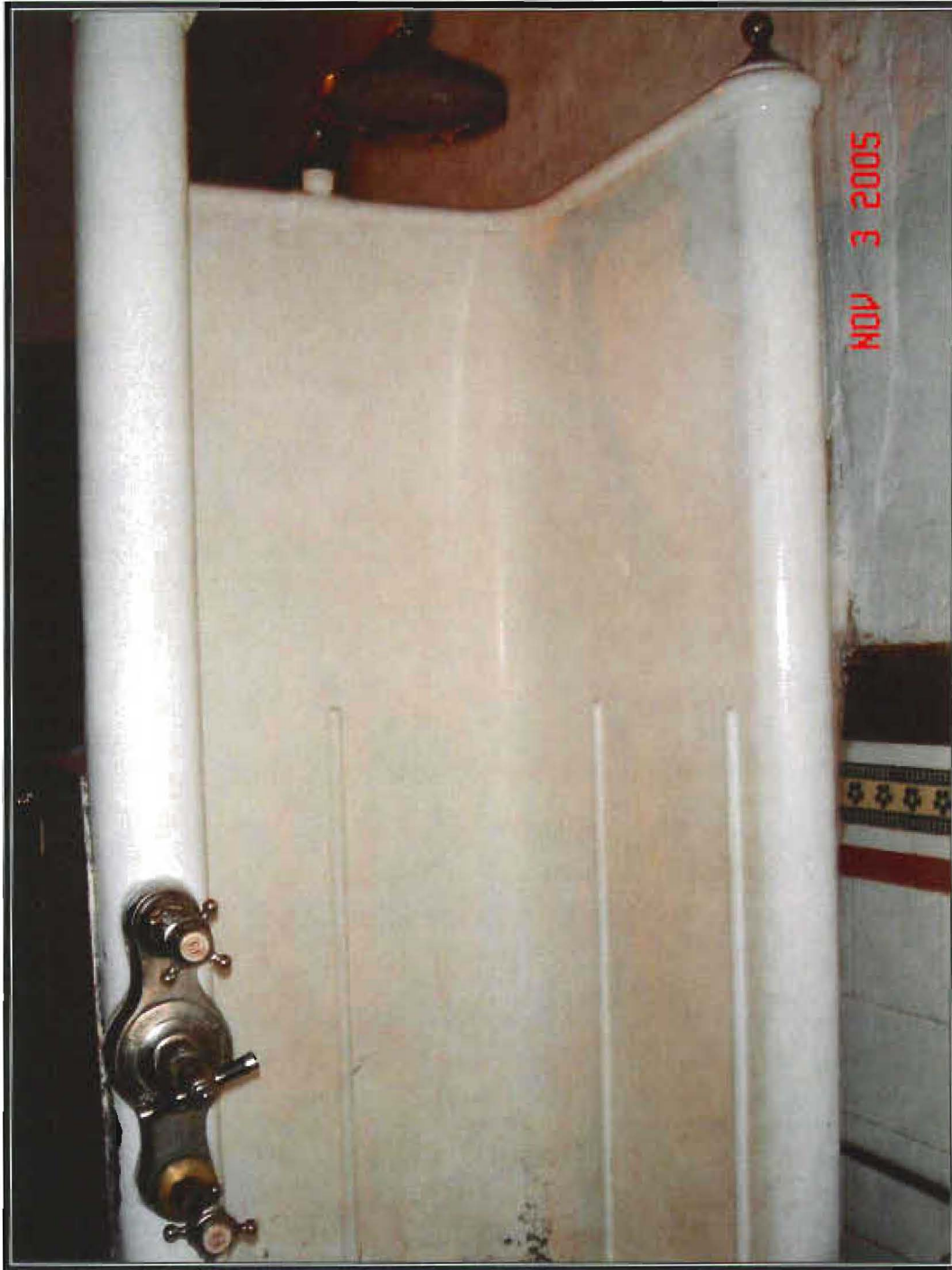
Illustratie 71 Die ingeboude stortbad, met lopende warmwater en verstellings: “Spray”, “lunge” en “shower” (1906), op De Rust. 484
