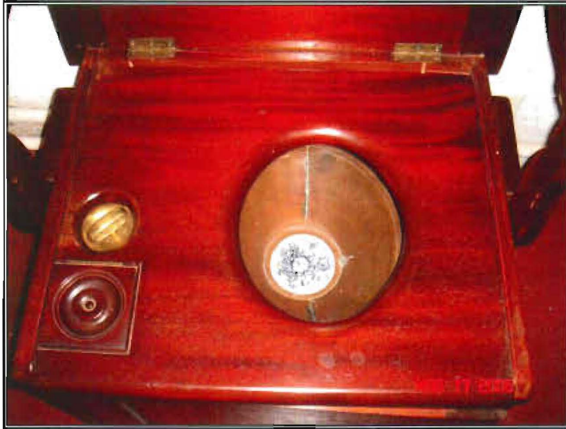
Illustrasie 77 Die draagbare emmertoeilet wat met water gespoel het op Zwartkoppies. 490
