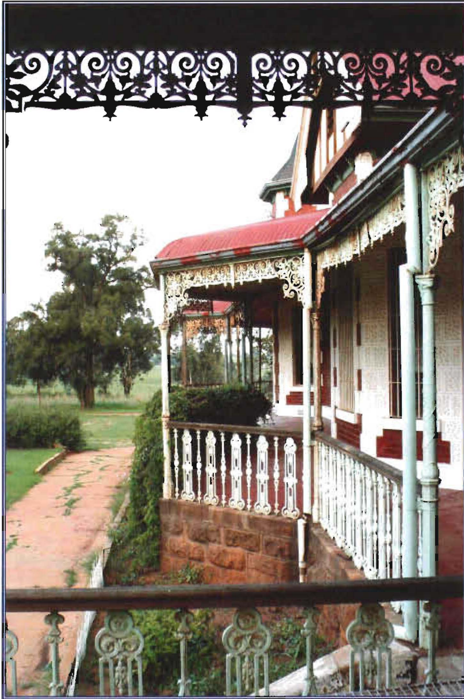
Illustrasie 39 Die suidelike stoep van die Victoriaanse plaasopstal op De Rust (1906). 263 Let op die geute wat die dak se reënwater na die blombeddings afvoer en die inheemse sandsteenfondamente.
