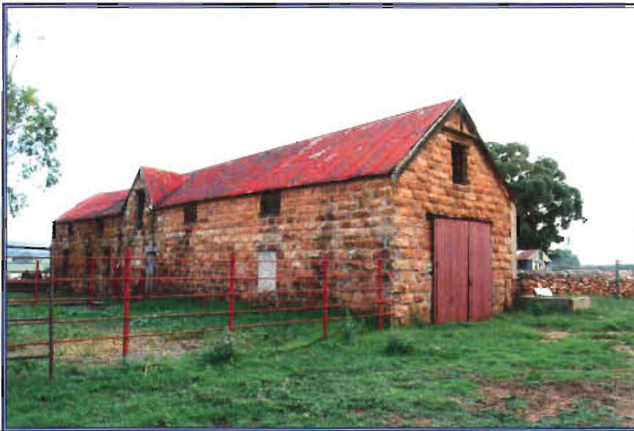
Illustrasie 13 Die waenhuis van gekapte klip op De Rust is een van die oudste staande strukture op die werf. 122 Let op die gepakte klipmuur (regs), wat die kleinwerf van die grootwerf skei.
