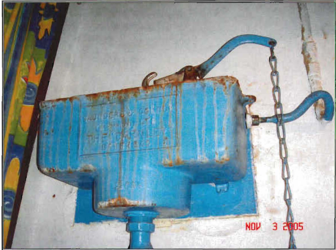
Illustrasie 80 Die kettingspoelstelsel, wat na 100 jaar, nog in gebruik is op De Rust. 493
