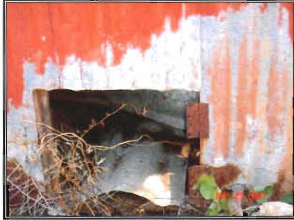
Illustrasie 75 'n Kleinhuisie met 'n emmerstelsel. Let op die skarniere (bo) waar die deurtjie was en die staandak hieronder (1.55 m x 1.58 m x 3.60 m). 488
