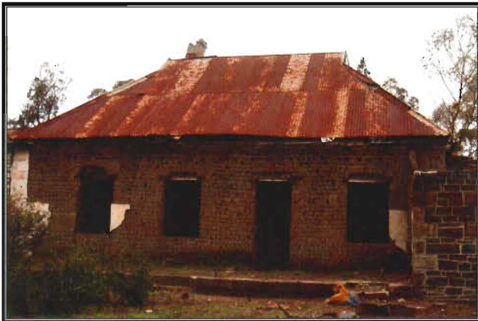
Illustrasie 33 Oorblyfsels van 'n klip-en-klei reghoekige pioniershuis ( \pm 1862) op Rietfontein, Heidelberg. Let op die vensteropening wat later met steen toegebou is, om as waenhuis te dien. 252 Hieronder: 'n reghoekige pioniershuis met songebakte kleisteenmure en 'n sinkdak op Middelspruit, Frankfort. 253
