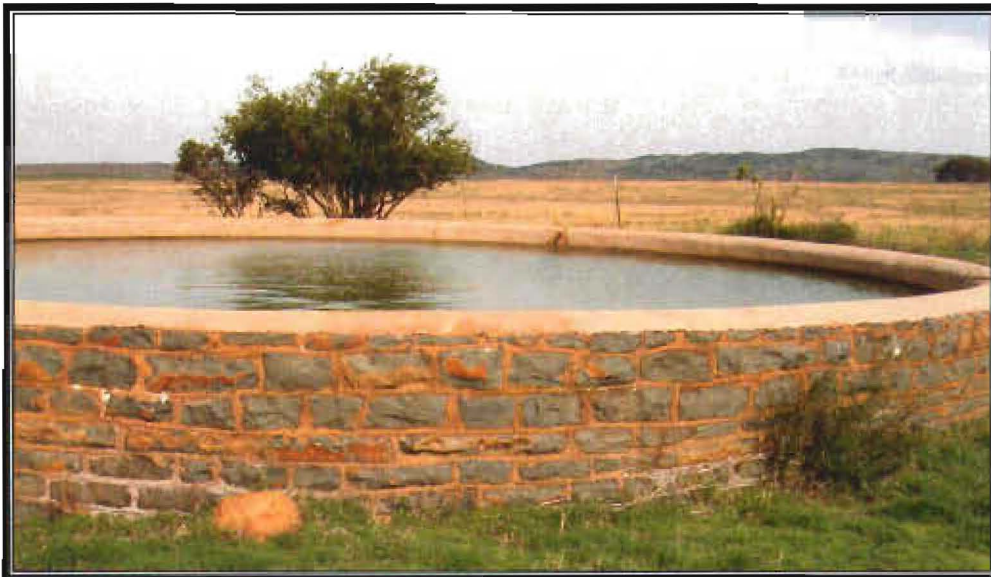
Illustrasie 15 'n Gemesselde gekapte blouklipdam ( \pm 1898) langs 'n boorgat, bokant die pioniershuis op Rietfontein, Heidelberg. 124
