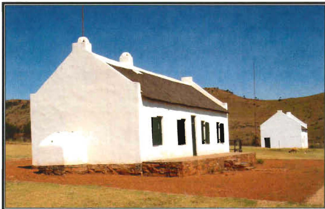
Illustrasie 34 Diepkloofplaasopstal (±1850). 254 Let op die klipfondament met die oop noordelike leiklipstoep en die witgekalkte mure. Die tuitgewels en nok is met 'n klei-en-kalkmengsel waterdig gemaak. Die huis bestaan uit 'n vyfvertrekgrondplan (onder) met 'n sentrale voorbuis, drie slaapvertreke en 'n kombuis met 'n vuurherd en binnebakoond. Skets: C. Gouws.
