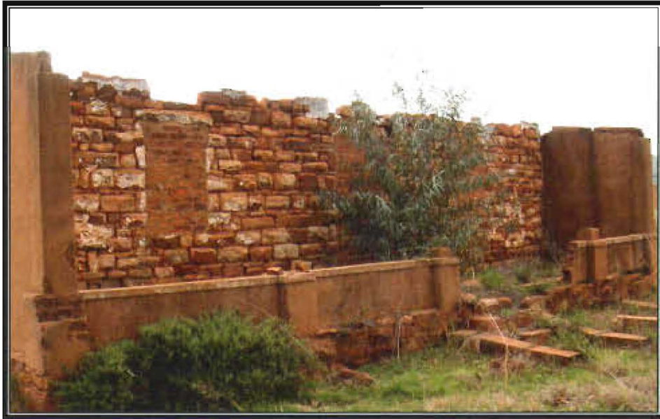
Illustrasie 33 Oorblyfsels van 'n klip-en-klei reghoekige pioniershuis ( \pm 1862) op Rietfontein, Heidelberg. Let op die vensteropening wat later met steen toegebou is, om as waenhuis te dien. 252 Hieronder: 'n reghoekige pioniershuis met songebakte kleisteenmure en 'n sinkdak op Middelspruit, Frankfort. 253
