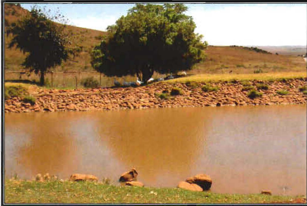
Illustrasie 14 Die klipwal van die eendedam in die kleinwerf op Diepkloof, Heidelberg. 123 Let op die wyse waarop die walle van die dam met klippe uitgepak is om erosie te voorkom.
