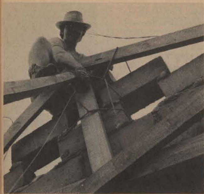
Die oprigting van die nuwe kerk se dak.
