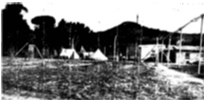
Leeukop-Interneringskamp van naby
