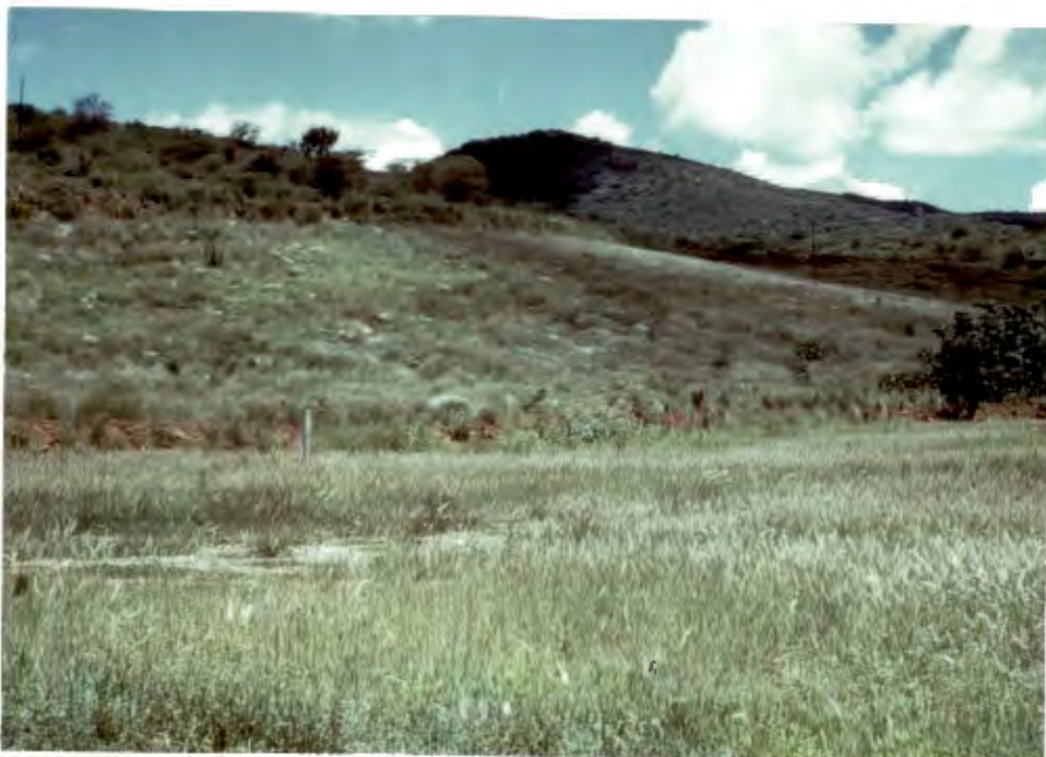
Plaat 5.5: 'n Amosiet-uitskothoop drie jaar na rehabilitasie (gesaai met 'n grassaadmengsel)
