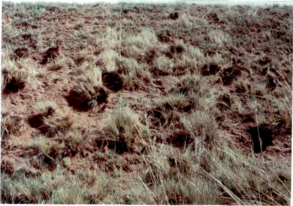
Plaat 3.9: Die agteruitgang van die plantbedekking teen 'n snyhelling as gevolg van die erodering van die bogrondlaag.
