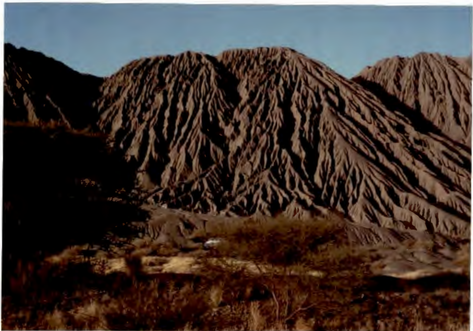
Plaat 3.4: Donga-erosie teen die kante van 'n uitskothoop van 'n diamantmyn
