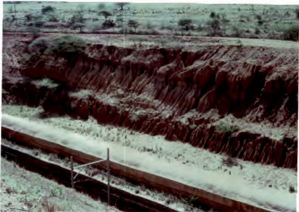
Plaat 3.9: Die agteruitgang van die plantbedekking teen 'n snyhelling as gevolg van die erodering van die bogrondlaag.
