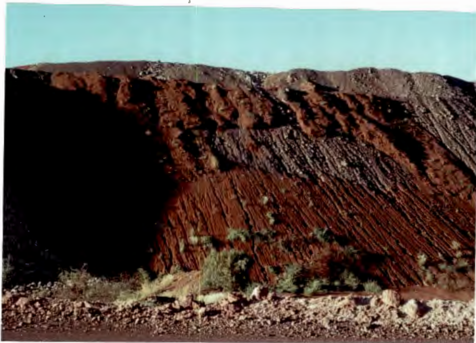
Plaat 3.11: Die boggronddeklaag teen 'n 35^{\circ} helling by SISHEN ysterertsmyne wat na slegs een seisoen grotendeels afgespoel het.
