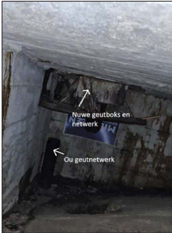
Figuur 3: Hierdie foto toon die oorspronklike en 'n nuwer geutnetwerk wat geïnstalleer is om die waterprobleme te probeer oplos. (Bron: F van Vuuren, 2021.)
