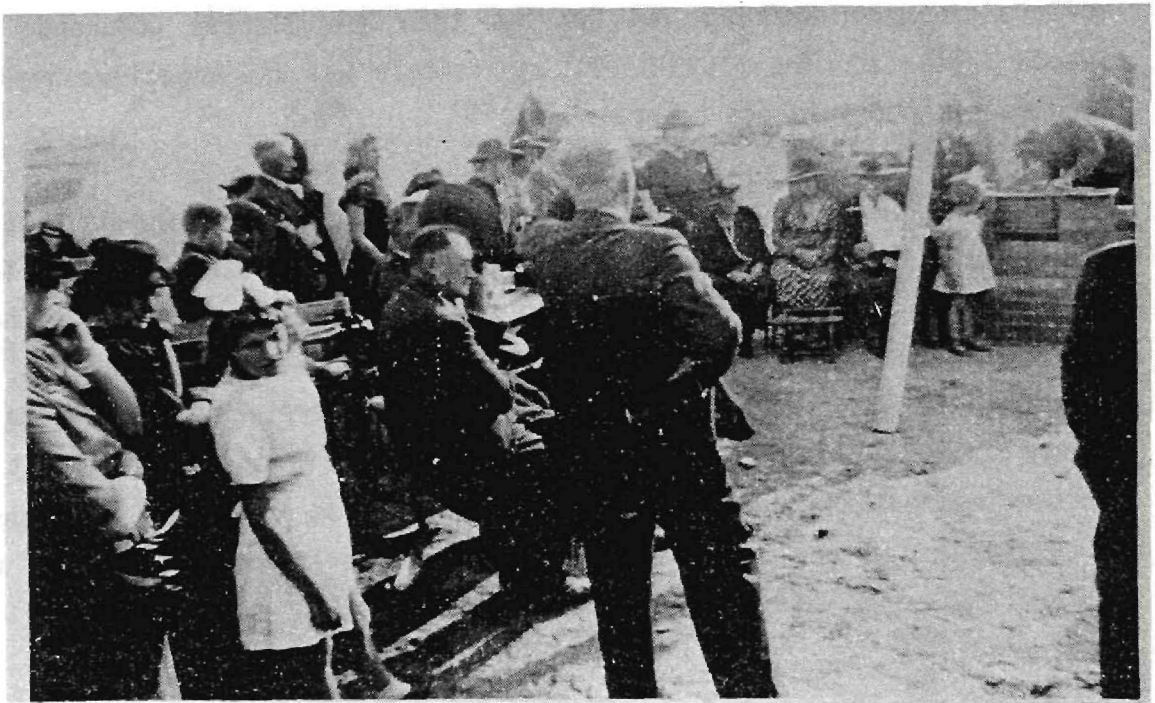
HOEKSTEENLEGGING VAN DIE SENDINGKERK TE FOCHVILLE, 1948 Foto: Nederduitse Gereformeede-Gemeente, Losberg (Fochville)
