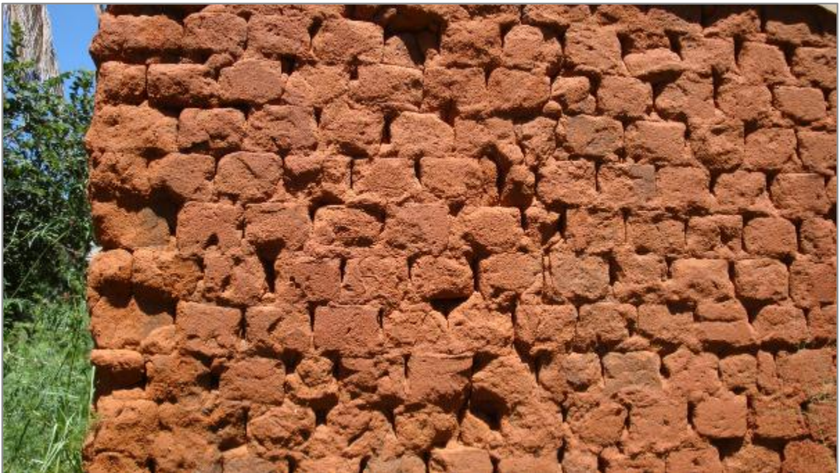
Figuur 41: Brandmerke op 'n gebrande steenmurasie 108
