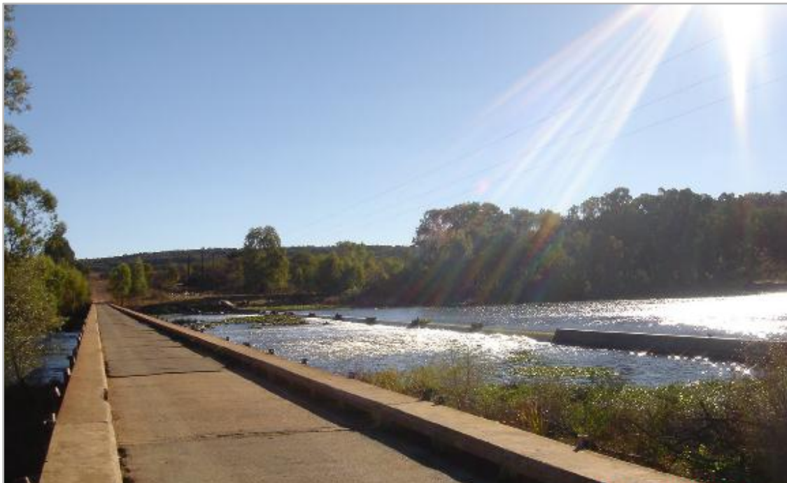
Figuur 60: Die keerwal bokant die Schoemansdriftbrug 302
