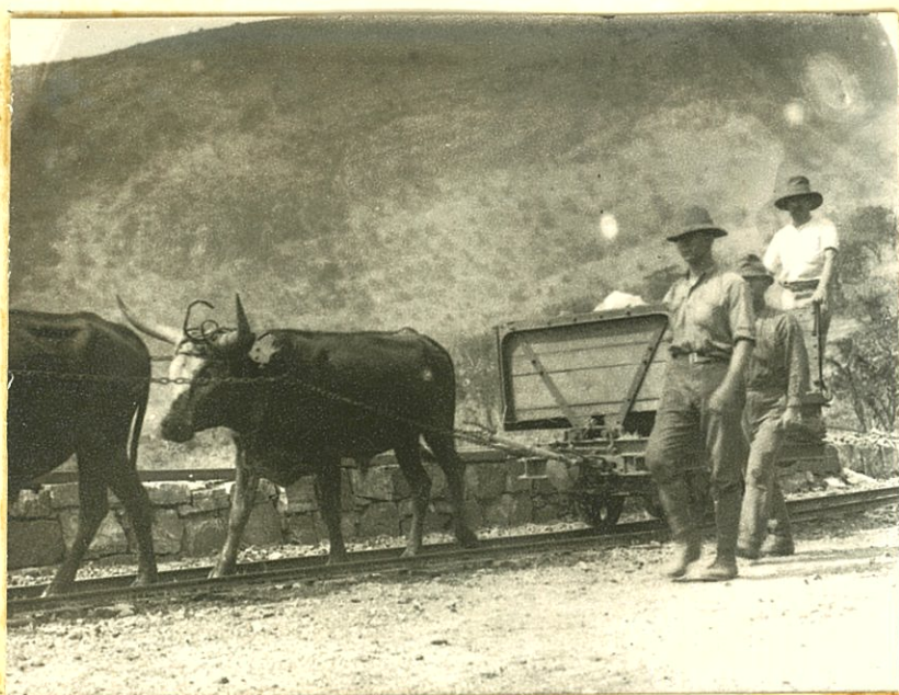
Die geduldige osse trek die trokke met materiaal na die plek van bestemming. Hierdie manier van vervoer het vanaf die einde van 1918 tot die helfte van 1919 toe 'n petroltrekker beskikbaar gestel is, voortgeduur.
