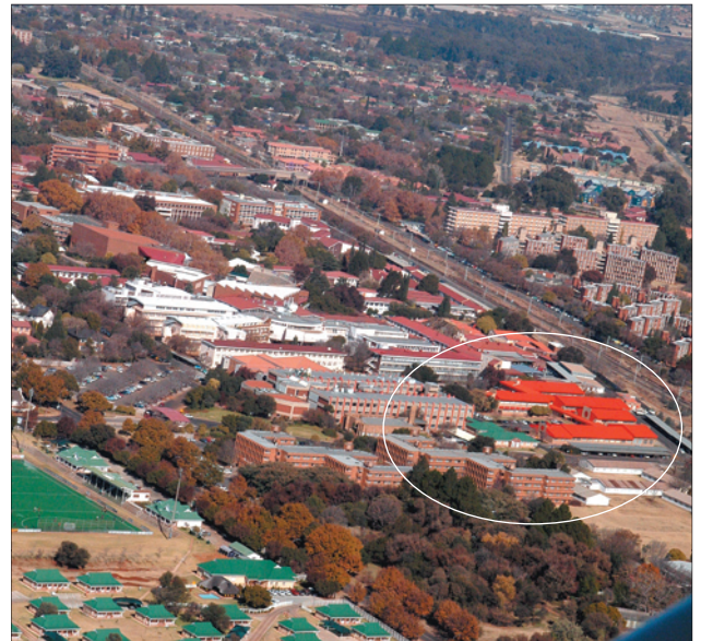
Die Ingenieurswese-gebou, PUK-kampus (Bron: Lugfoto, A. Geldenhuis, Nov. 2004)
