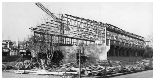
Die Meganiese Ingenieurswese-gebou in aanbou. Ten tyde van die oprigting was dit die duurste bouonderneming op die kampus (Bron: PUK-Argief)
