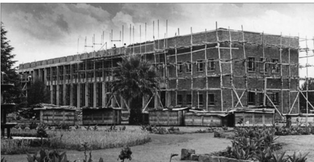
Die Ferdinand Postma-biblioteek in aanbou in 1950. Op die voorgrond is die verkeersirkel wat voor die Hoofgebou was.
