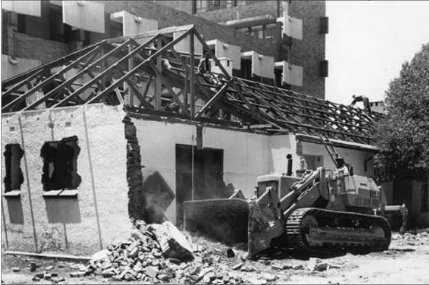
Piet Grobler-huis word gesloop om 'n parkeerterrein vir die Ekonomiese Wetenskapgebou te voorsien. Hierdie gebou is sigbaar in die agtergrond (Bron: PUK-Argief)
