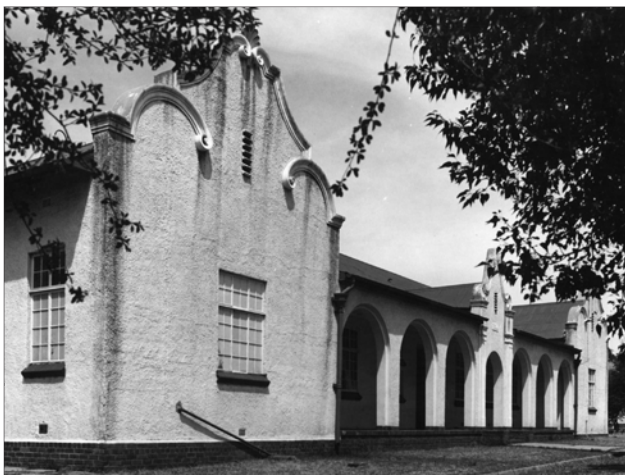
Die ou Fisika-gebou (na 1998 bekend as die Voeding en Gesinsekologie-gebou). Die vooraansig is in Kaaps-Hollandse styl wat tiperend was van die eerste geboue (Bron: PUK-Argief)
