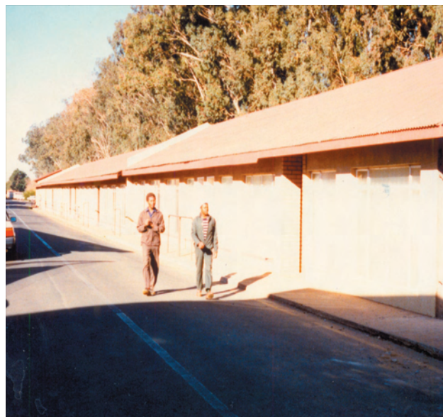
Die sinkgeboue langs die treinspoor wat vir jare as die administrasiekantore van die PUK gedien het (Bron: PUK-Argief)
