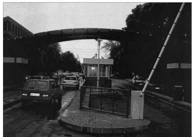
Die toegangsbeheerhek in Hoffmanstraat (Bron: Openbare Betrekkinge-elektronies)
